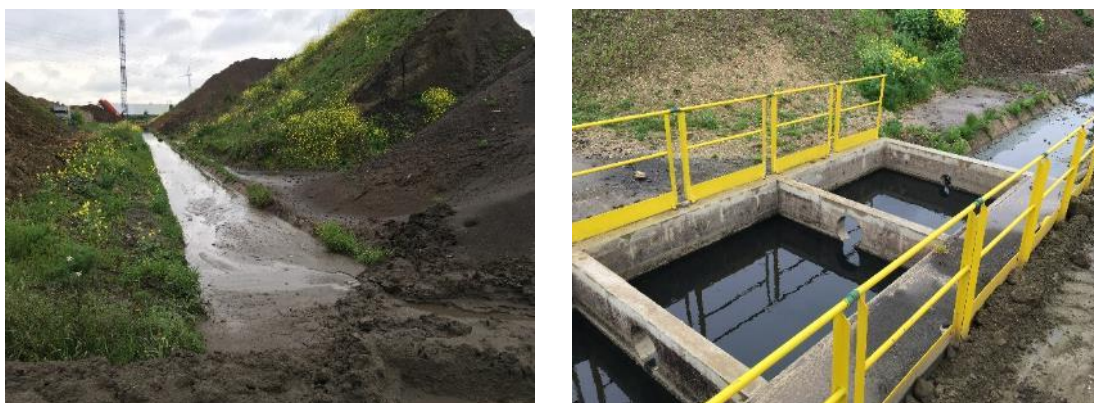
Figuur 1: Beeld van de centrale gracht en bezinkputten waarin deze uitmondt.
