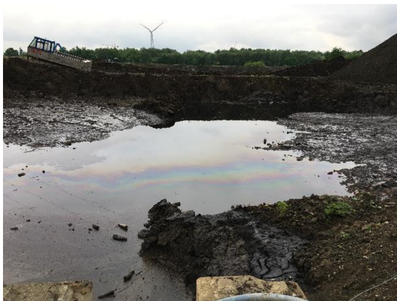
Figuur 4: Compartiment voor rioolkolkenvuil
